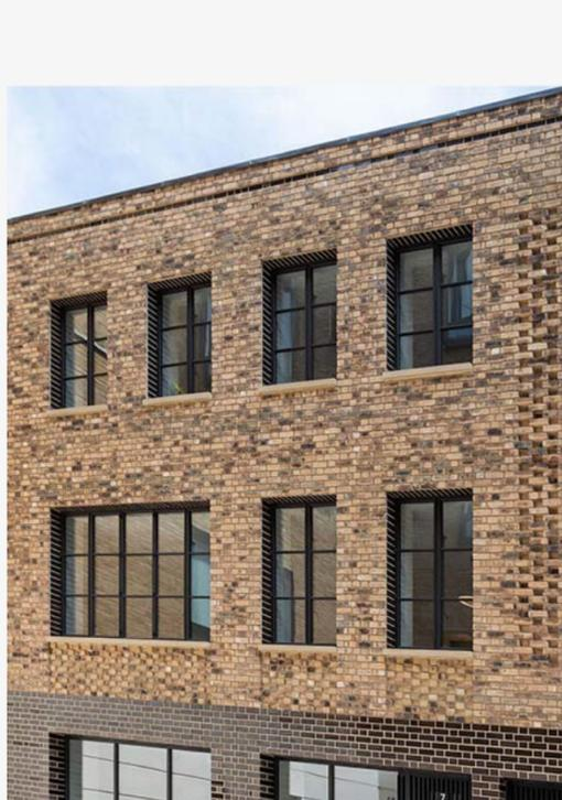
Der Architekt konnte seiner Inspiration in den Bricks aus emailliertem Lavastein freien Lauf lassen und entschied sich für eine **farbintensive Kreation**. Die für Fassadenverkleidung, aber auch die Fenster- und Türumrahmungen angefertigten Bricks und Bordüren aller Art entsprechen in allen Einzelheiten dem Entwurf der Planer.
